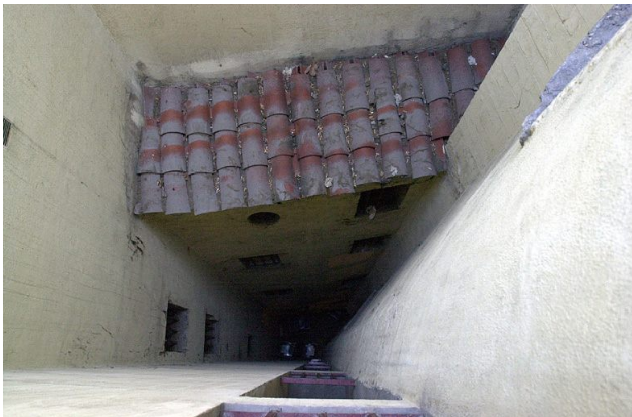
Cour nord : vue en plongée depuis la galerie
