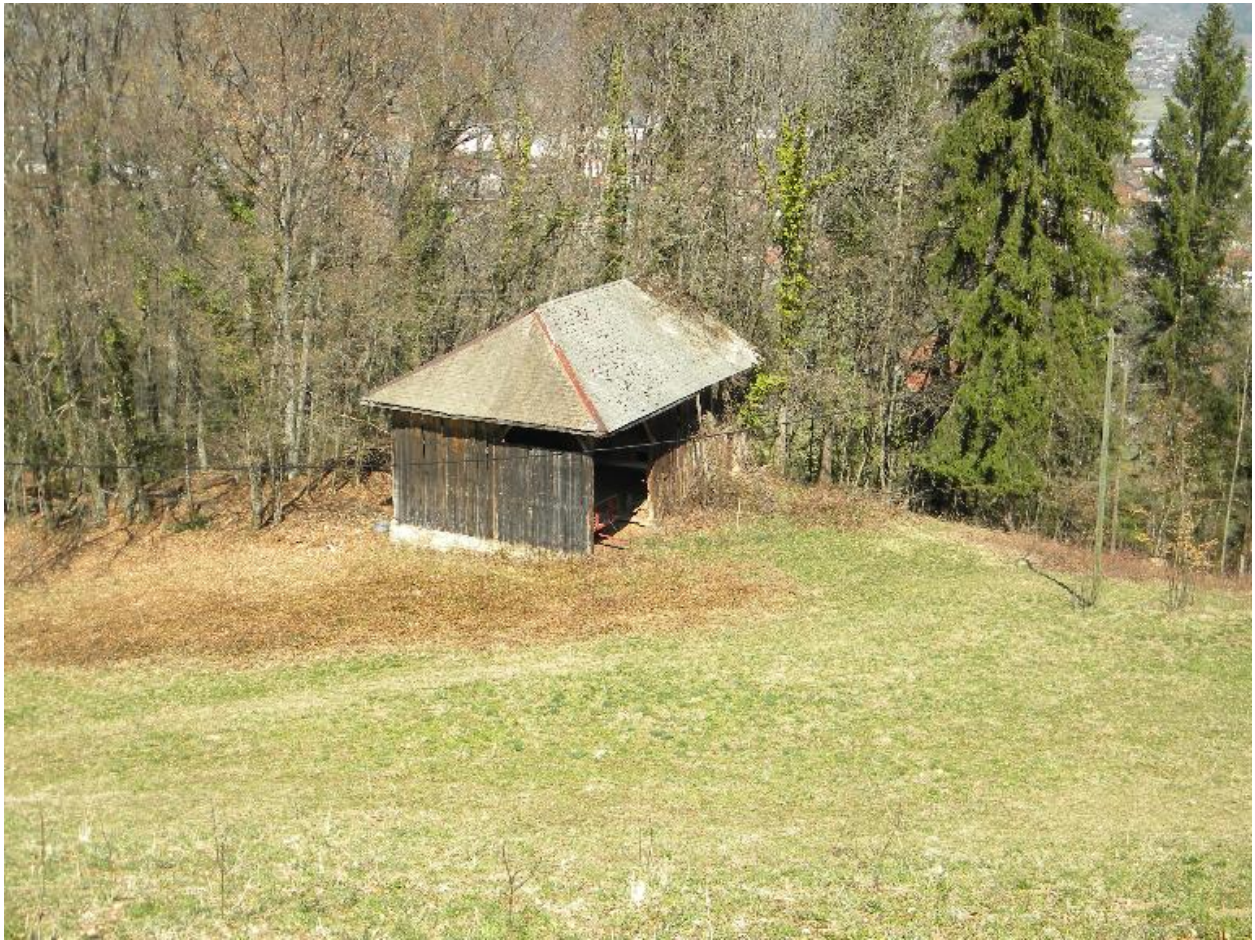
Vue générale d'une grange étable isolée (2008 F6 749).
