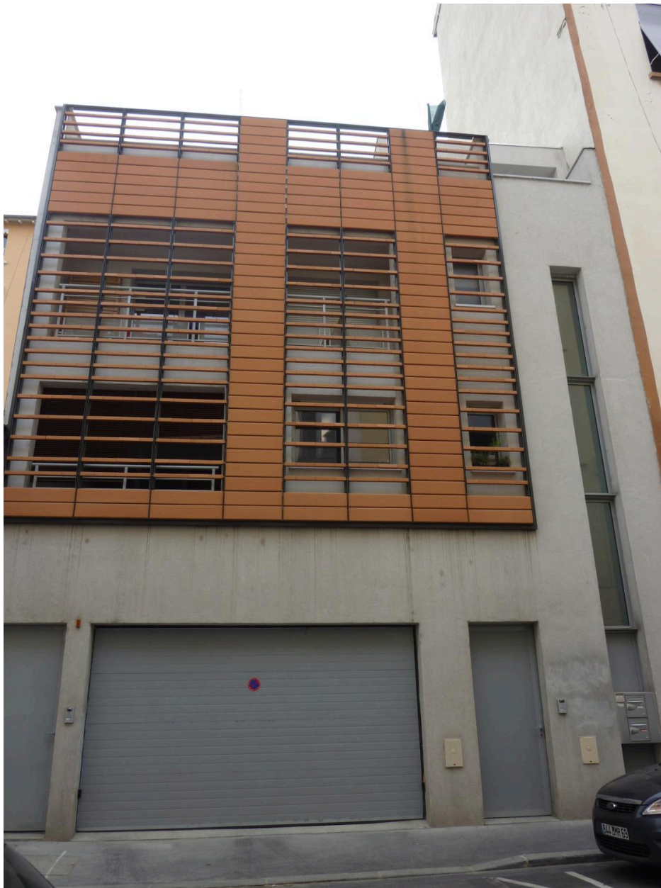
Immeuble 22 rue du mail vue d'ensemble
