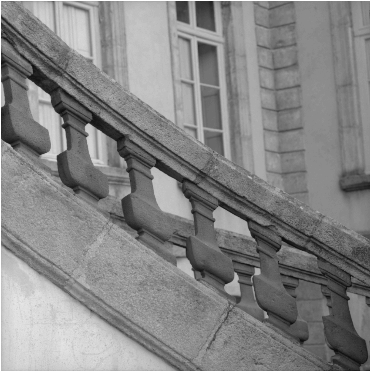
Détail de la façade sur jardin : balustres en andésite de l'escalier en fer à cheval.
