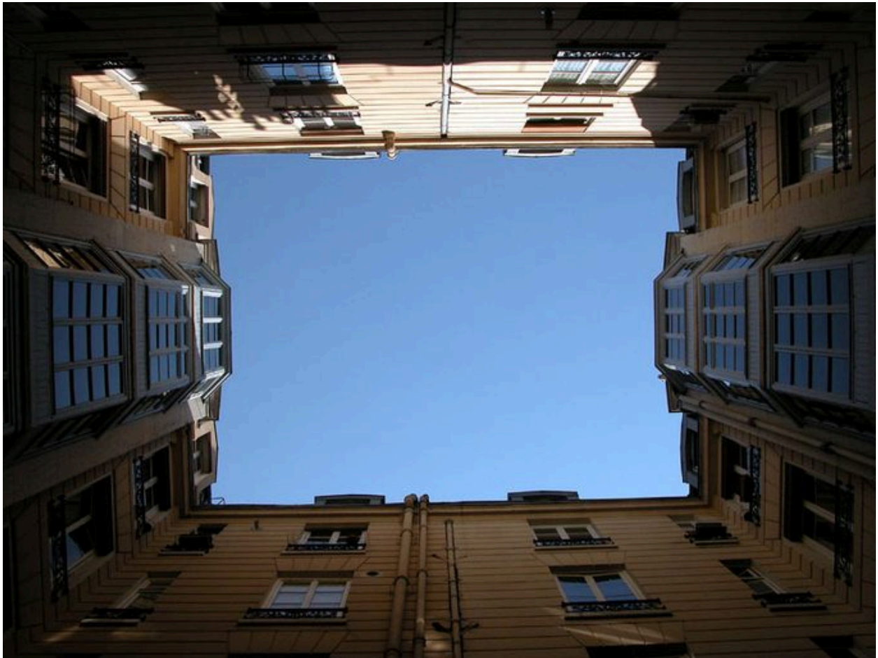
Vue de la cour en contre-plongée
