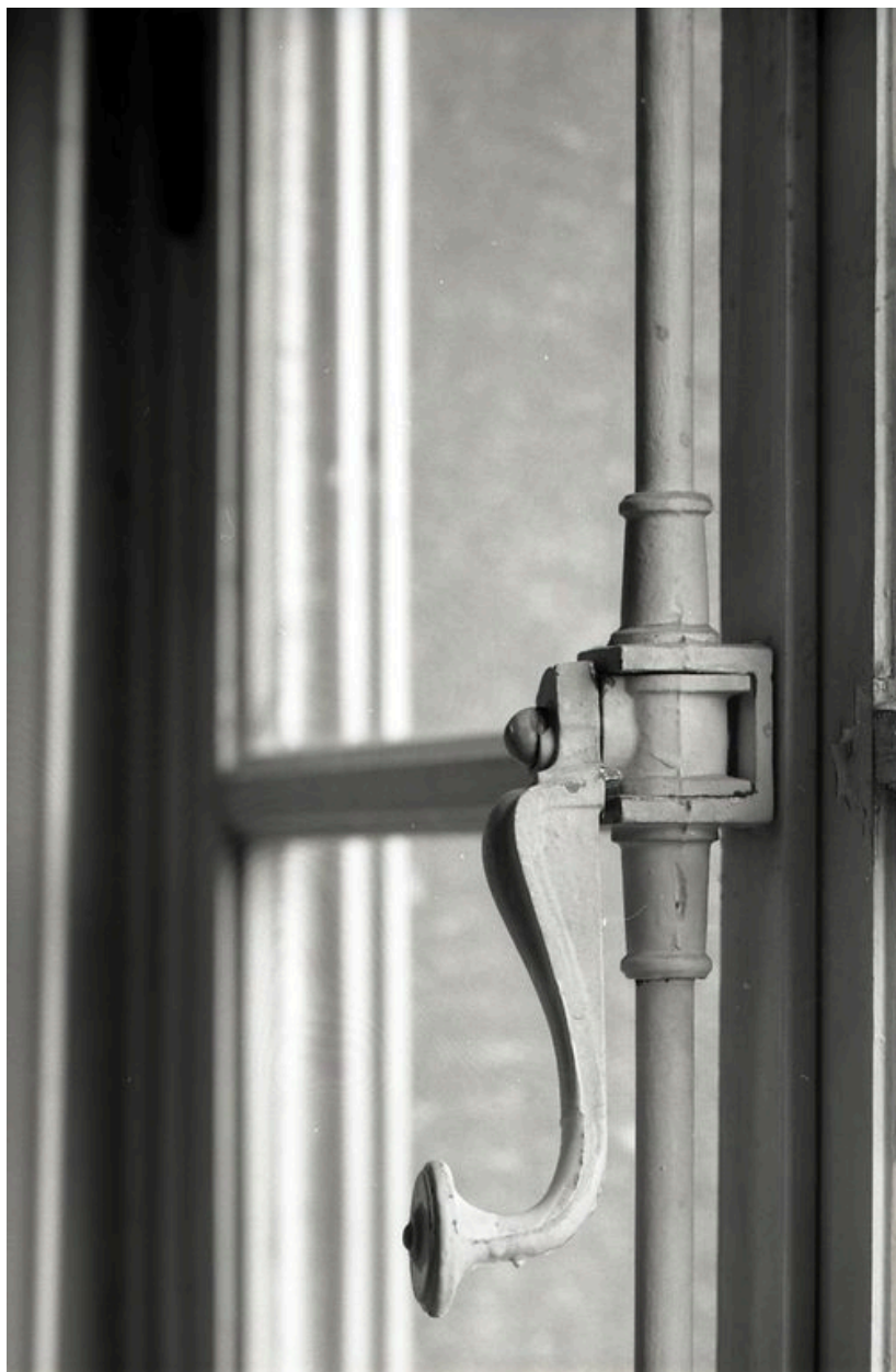
Ecole de filles. Détail d'une espagnolette, fenêtre d'origine d'une classe
