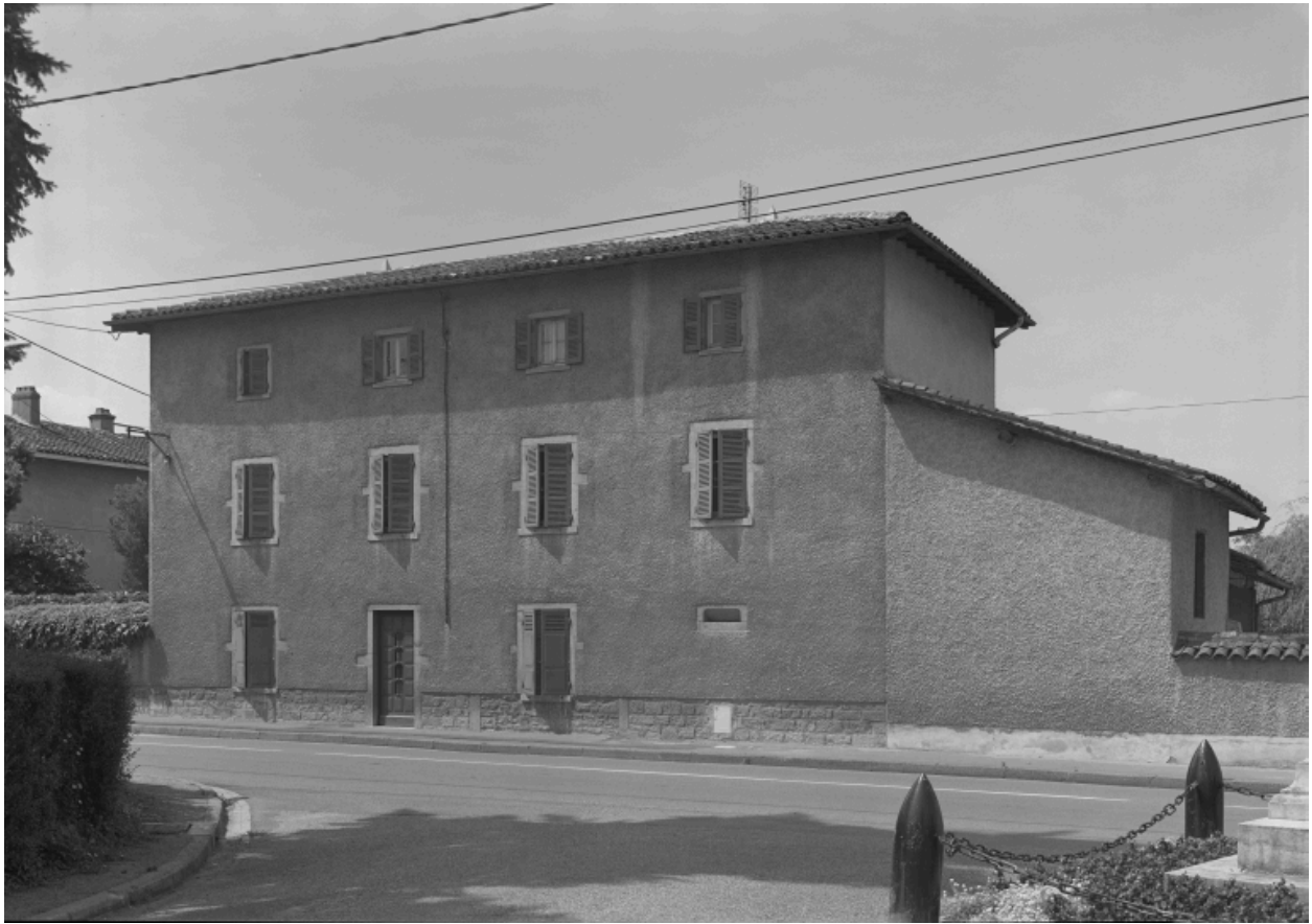
Maison de type V, Jassans-Riottier, 1376 rue Edouard Herriot : maison individuelle en pisé, construite en 1870.
