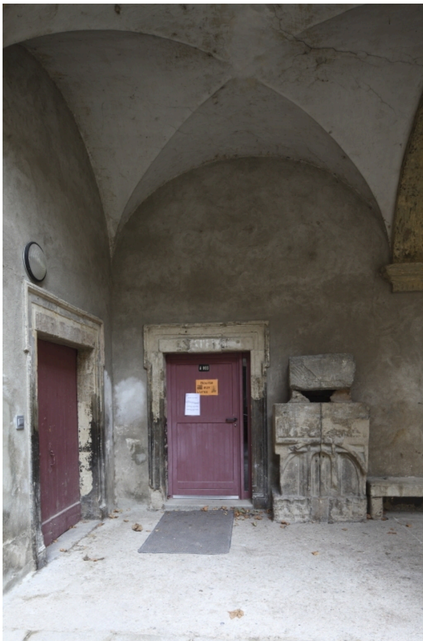
Bâtiment A, cour, galerie nord, angle nord-ouest.
