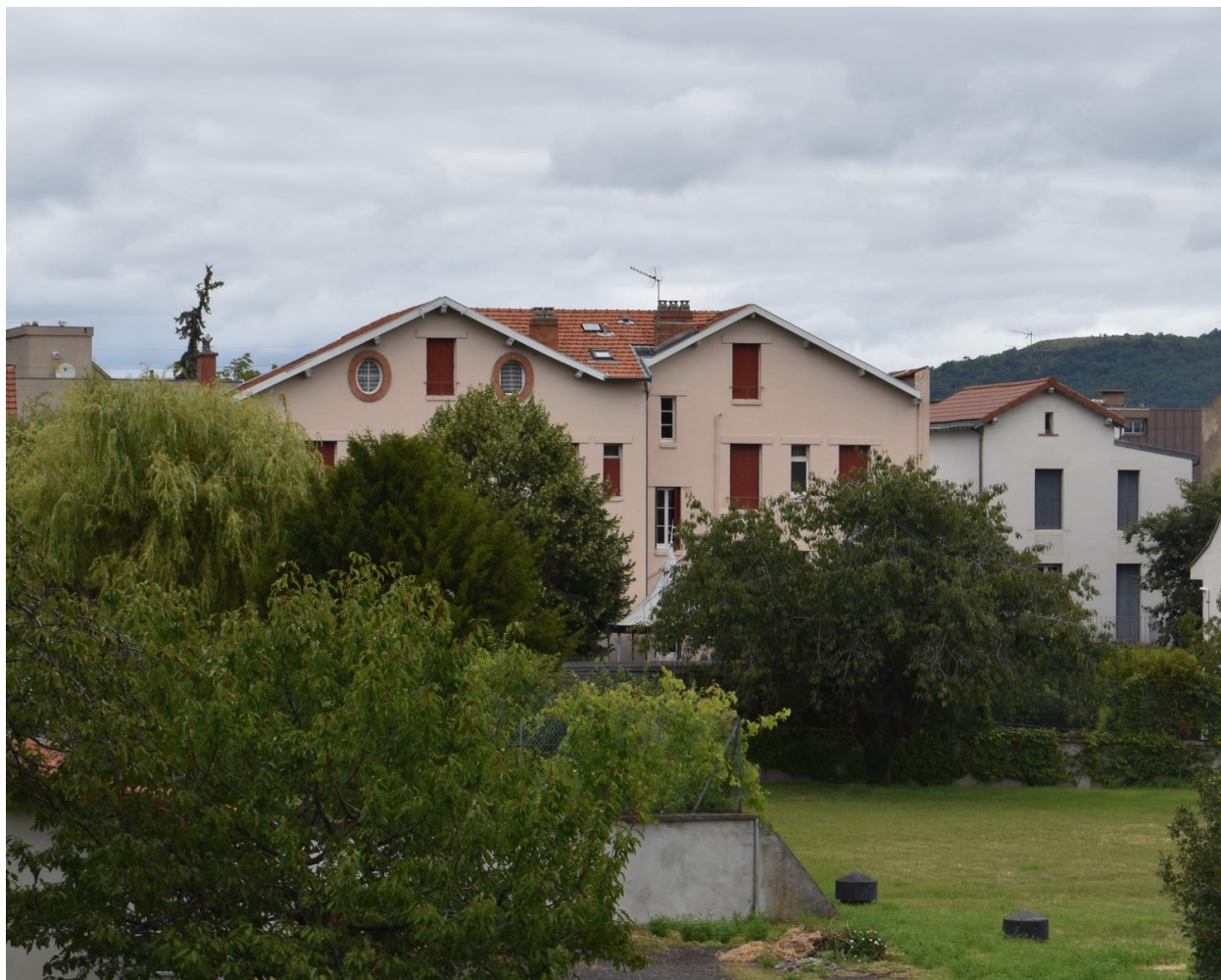
Vue de l'élévation postérieure de la Villa Mon Désir
