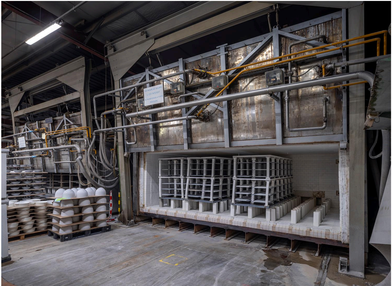
Four électrique : usine de céramique culinaire "Revol porcelaine"
