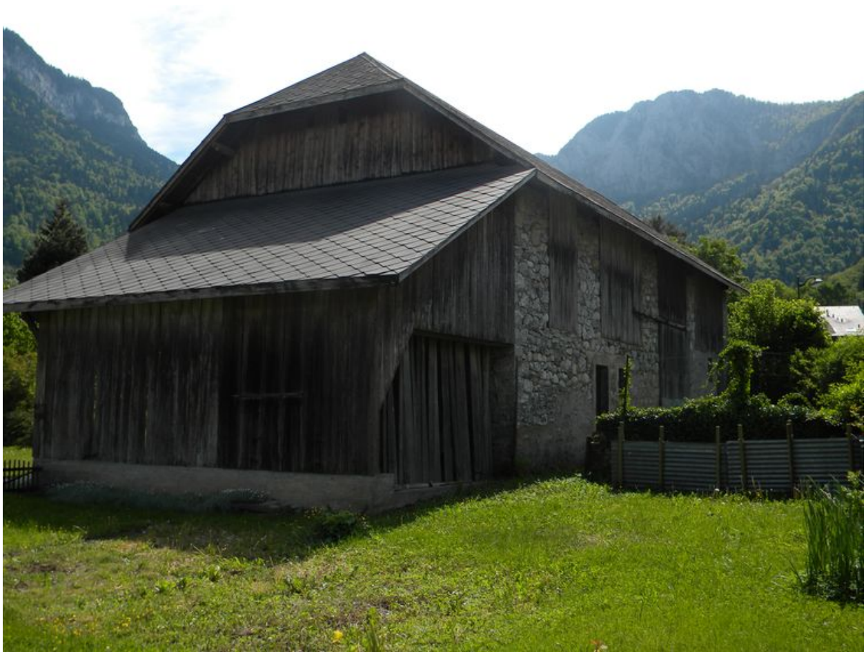
Vue de la façade arrière du bâtiment agricole.
