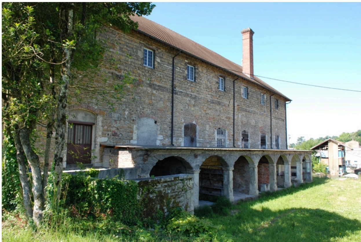
Façade nord de la forge
