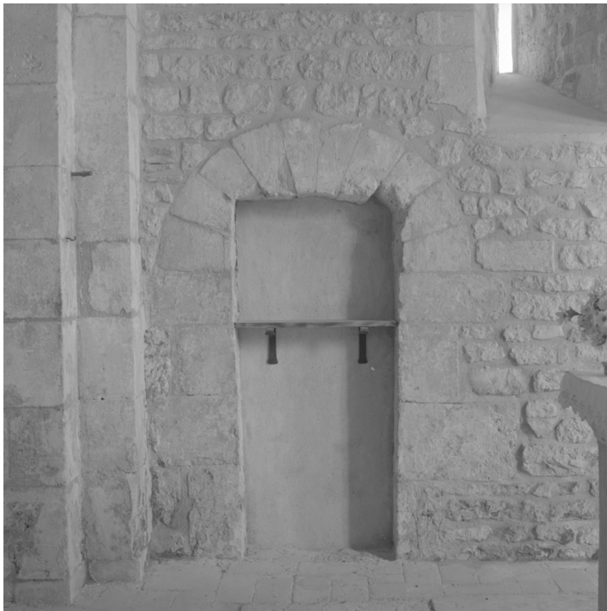
Porte murée (travée de chœur, mur nord).
