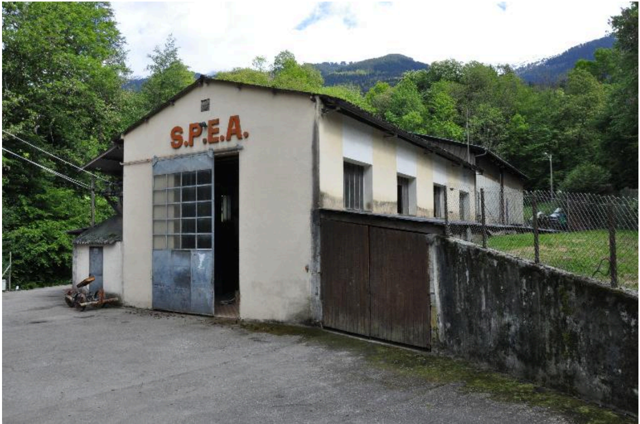
Vue de la centrale.
