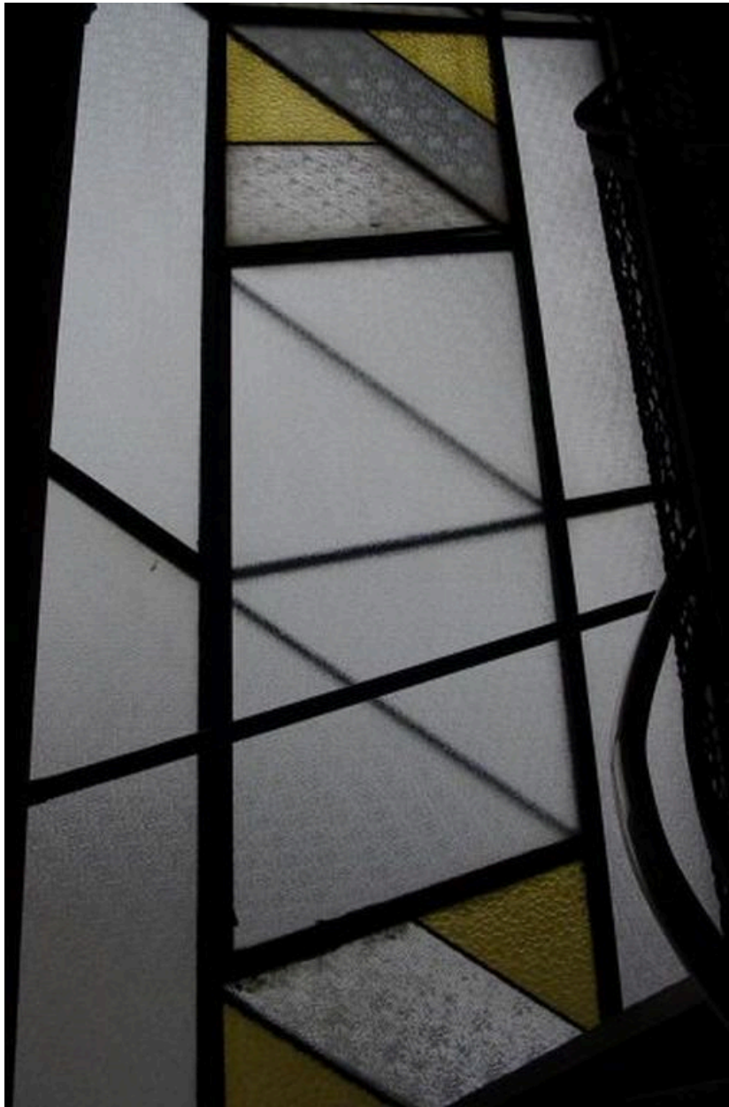
Vue intérieure des vitraux éclairant la cage d'escalier
