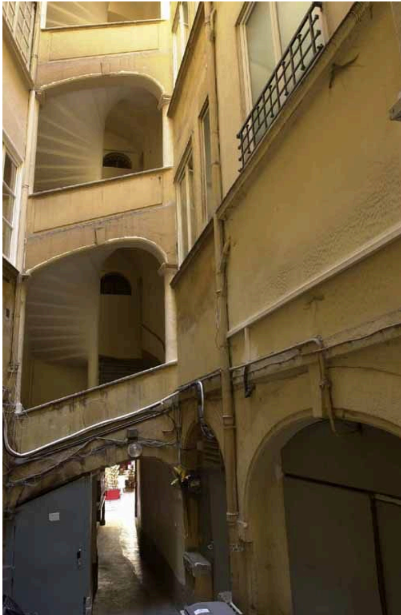
La cage d'escalier desservant le corps de bâtiment ouest
