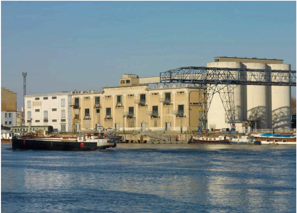
Vue d'ensemble sud ouest avant travaux de reconversion.
