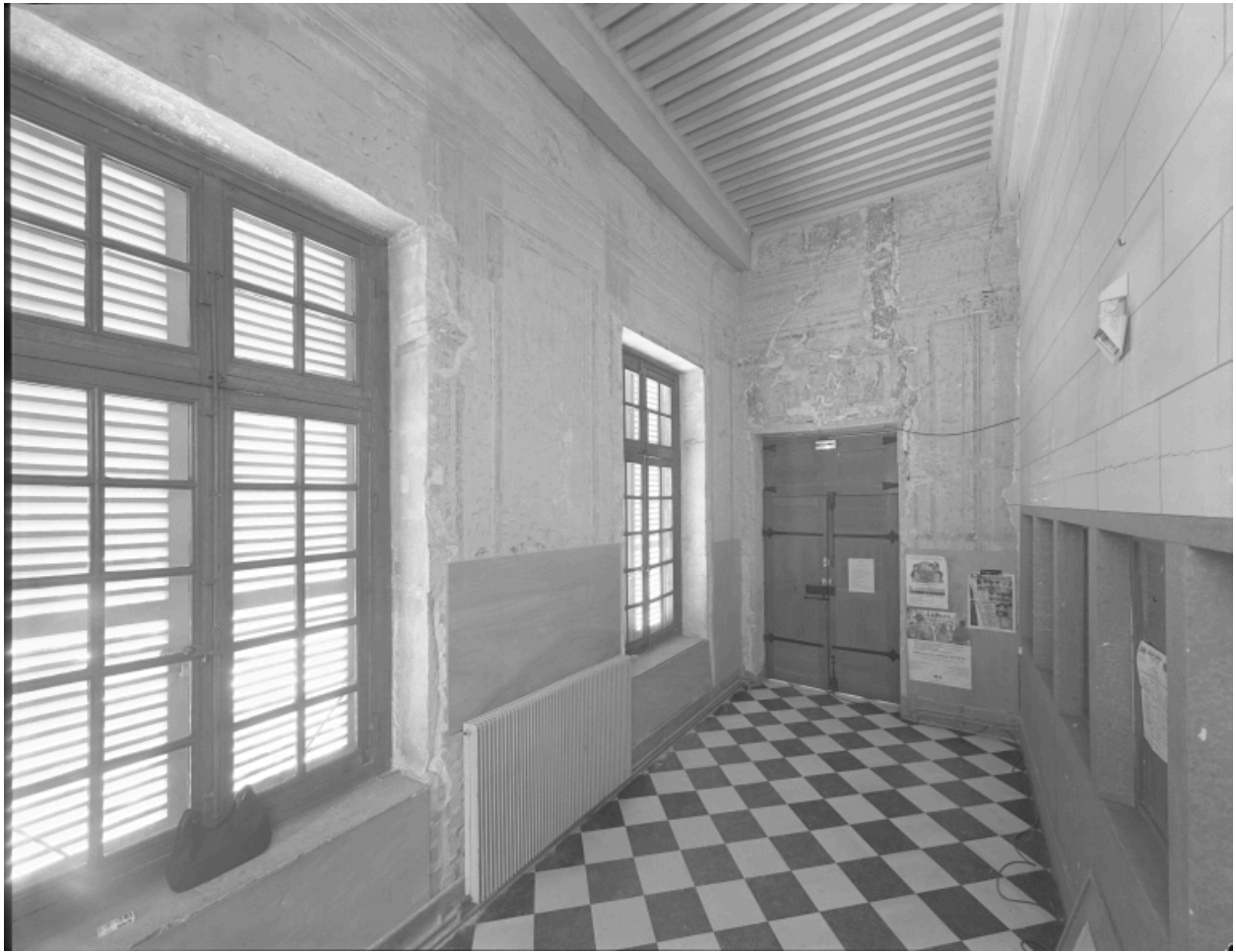
Vue d'ensemble de la salle, actuellement coupée par une cloison.
