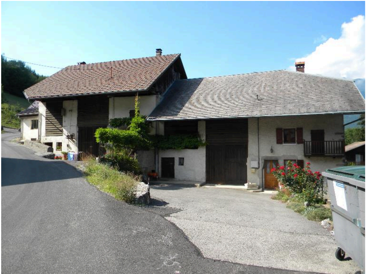
Vue d'un alignement de fermes à la sortie nord du hameau (2008 F7 893,894,895)
