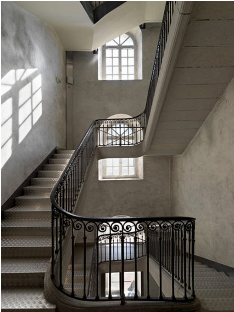
Escalier secondaire au nord est du bâtiment principal.
