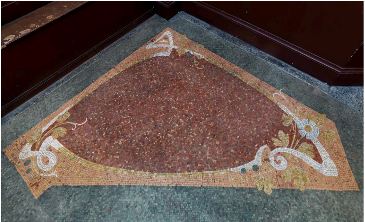
Brasserie La Taverne : revêtement de sol en mosaïque, motif d'angle situé près de l'entrée
