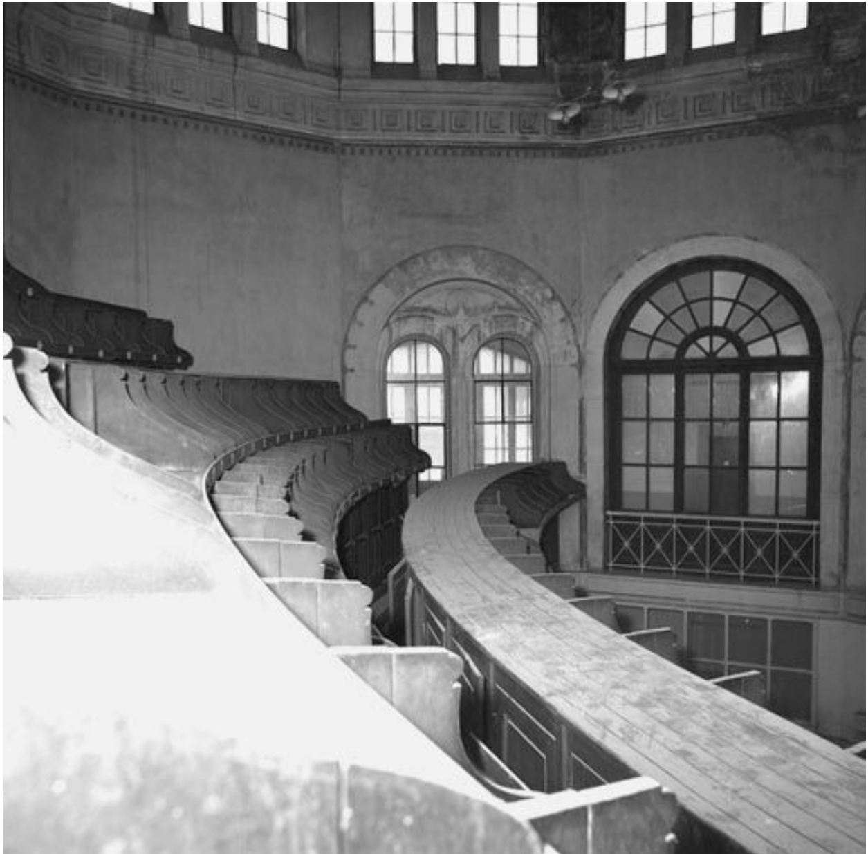
Chapelle : les gradins vus du dessus, état en 1984
