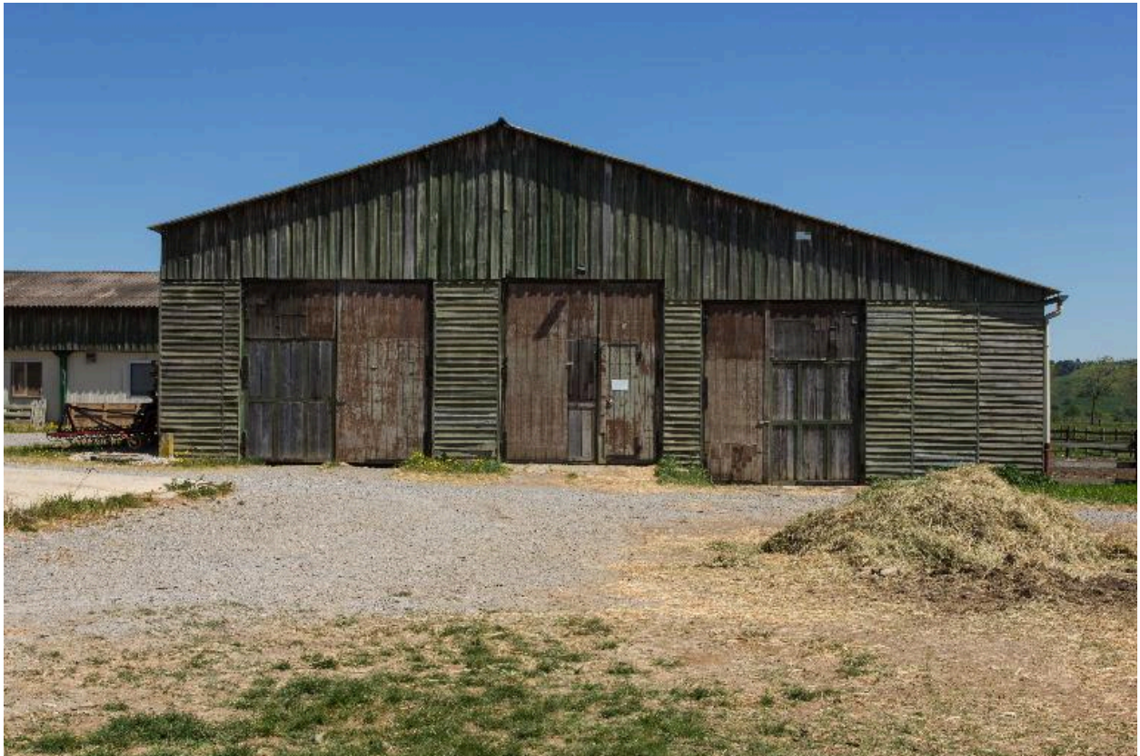
Ferme caprine : aile sud ouest, au fond la fromagerie
