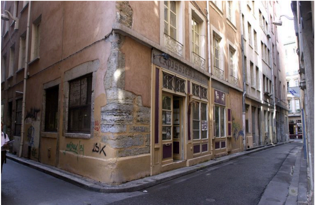
Façade principale rue du Major Martin, entrée d'atelier
