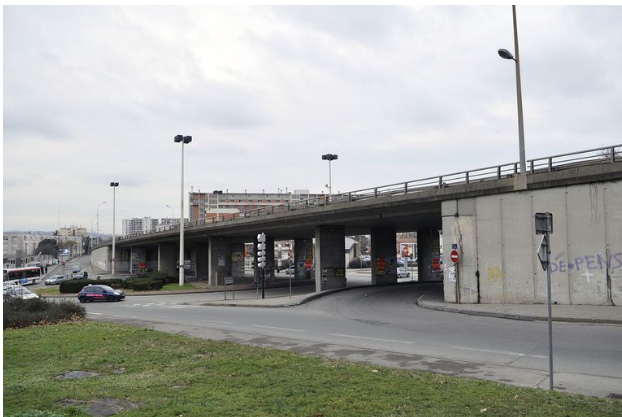
Vue en situation depuis le sud-est
