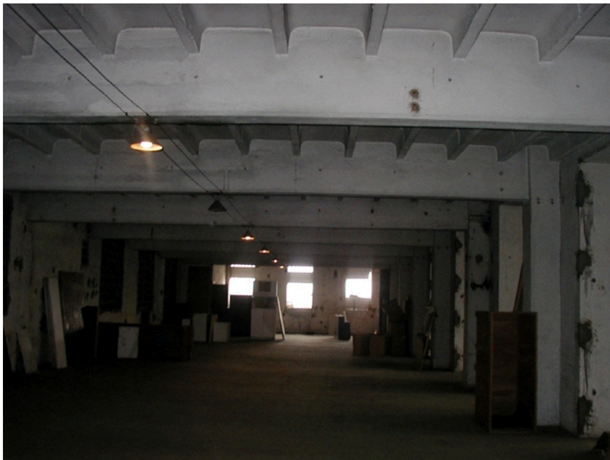
Vue du premier niveau, détail poutrelles béton
