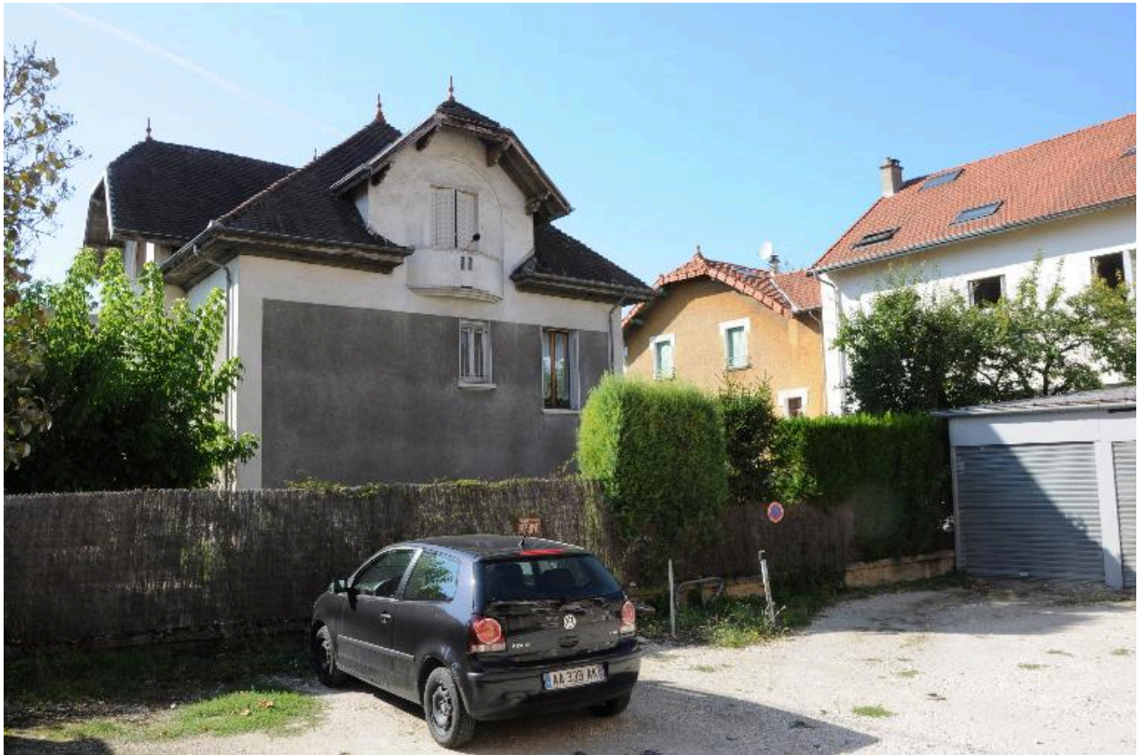
Façade latérale est
