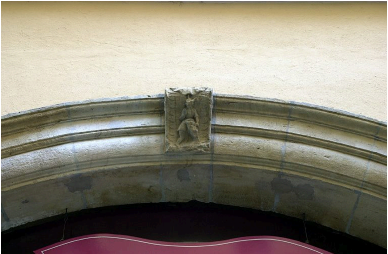
Elévation rue de la Monnaie, rez-de-chaussée : agrafe de l'arcade de gauche
