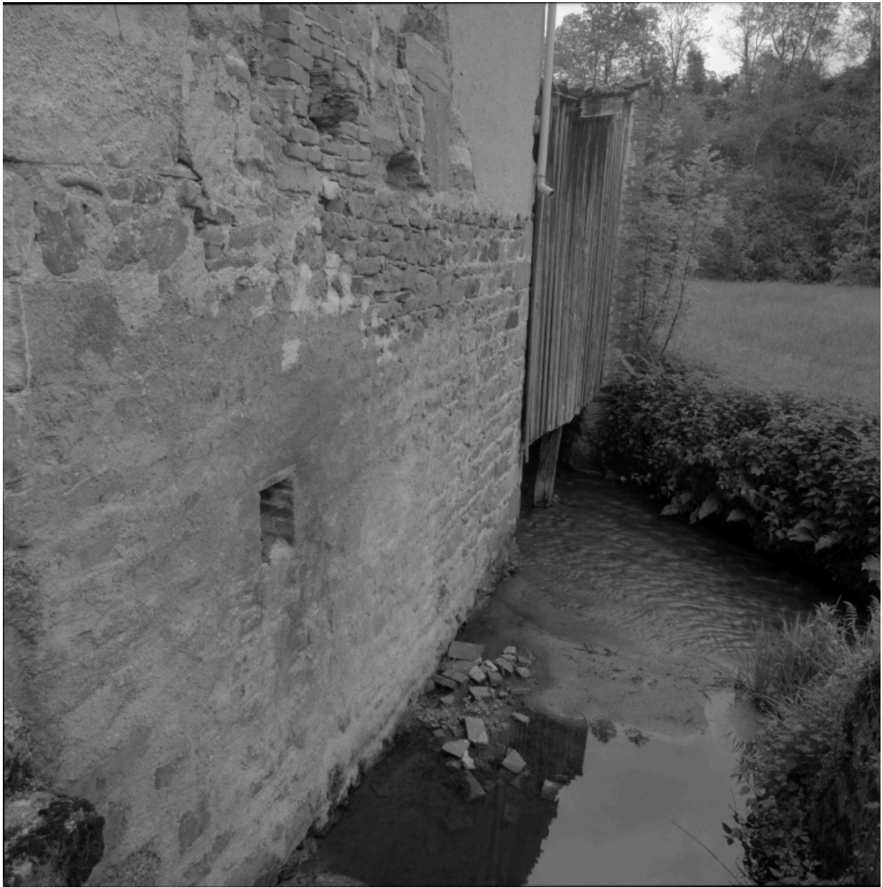
Vue du béal à la sortie du moulin.
