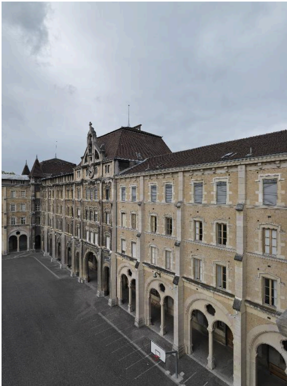
Cour, élévation principale, depuis le nord
