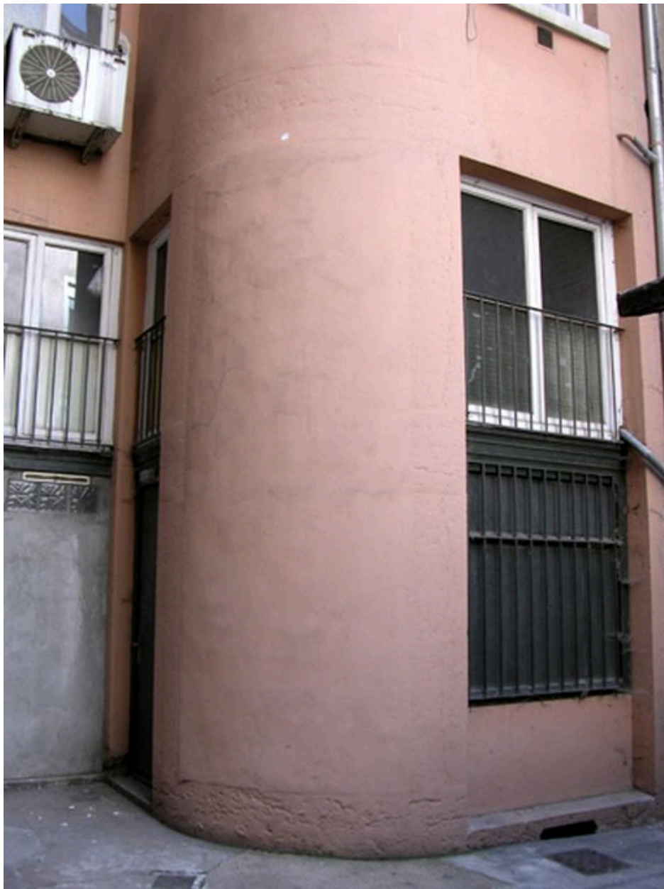
Détail de la façade postérieure du corps de bâtiment avenue Jean-Jaurès
