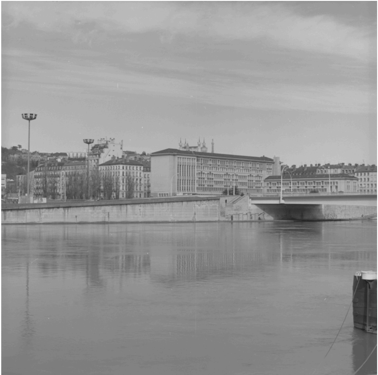
Vue générale depuis le sud-est
