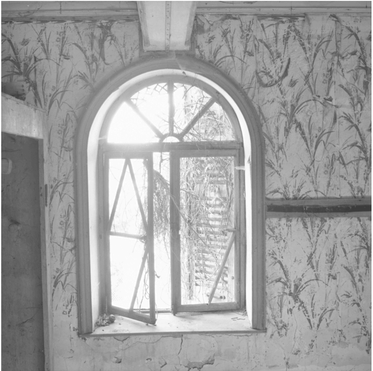
Rez de chaussée surélevé, vue de l'intérieur : fenêtre et papier peint.
