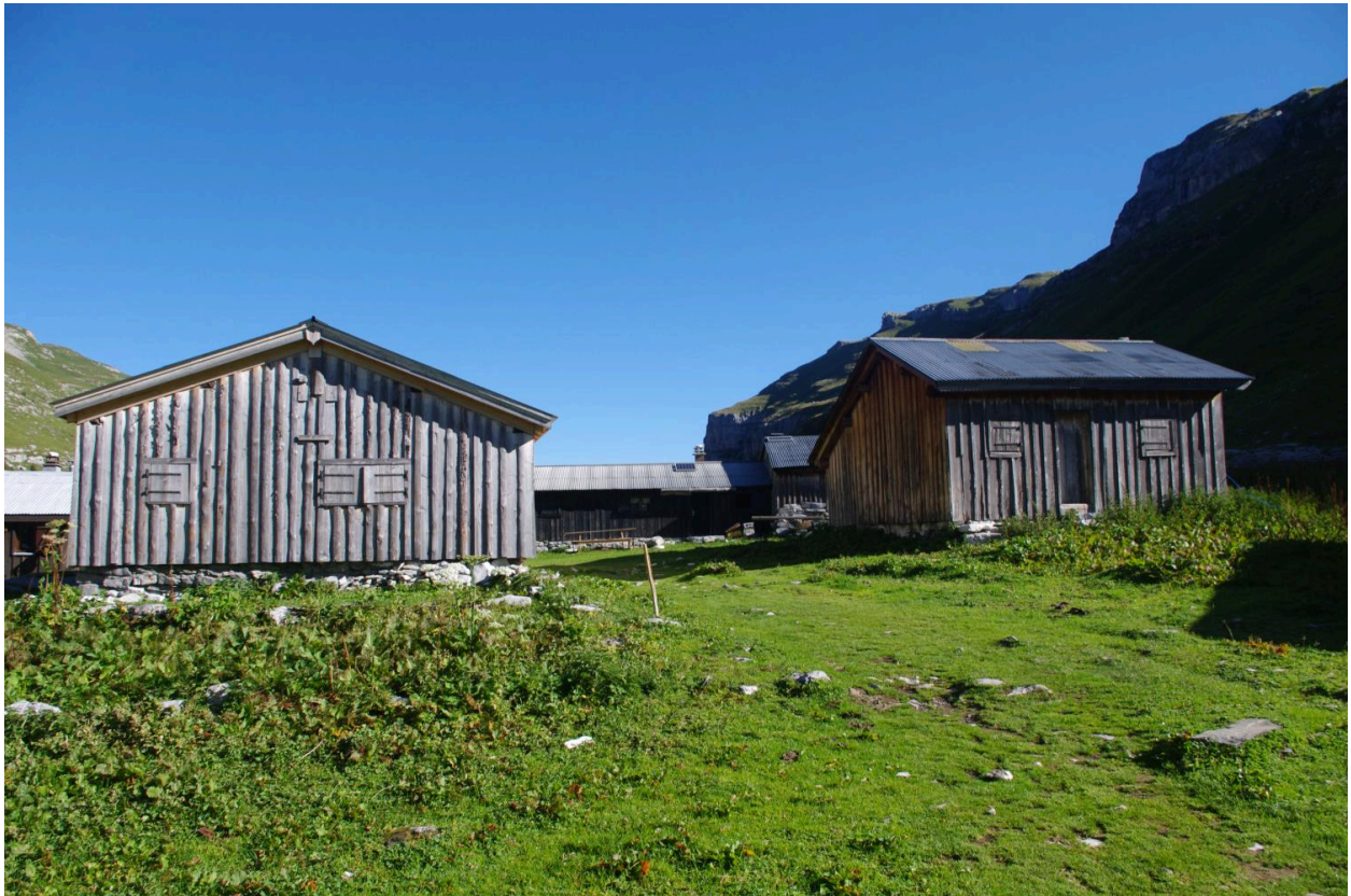
Vue du mur pignon sud
