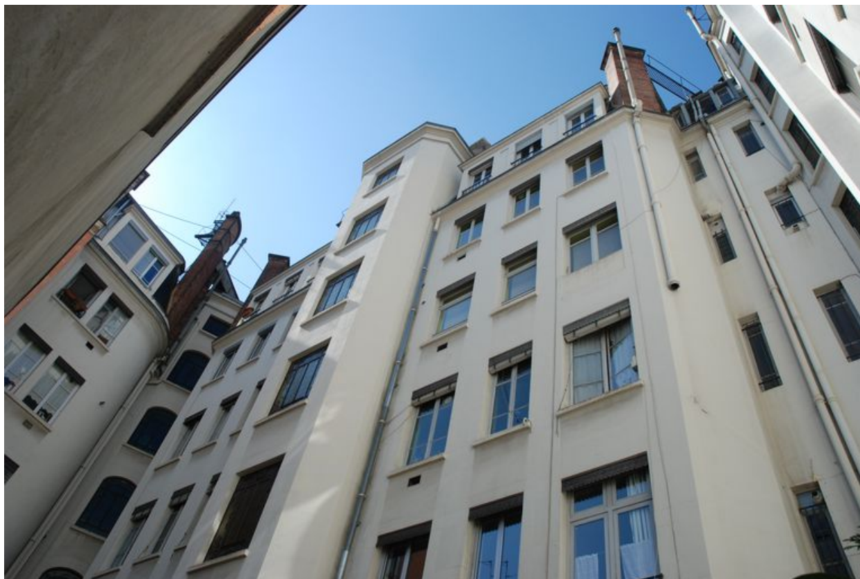
Elévation sur cour, vue des parties hautes
