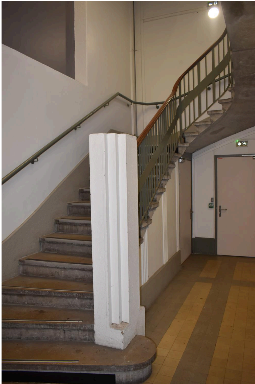
Détail escalier principal
