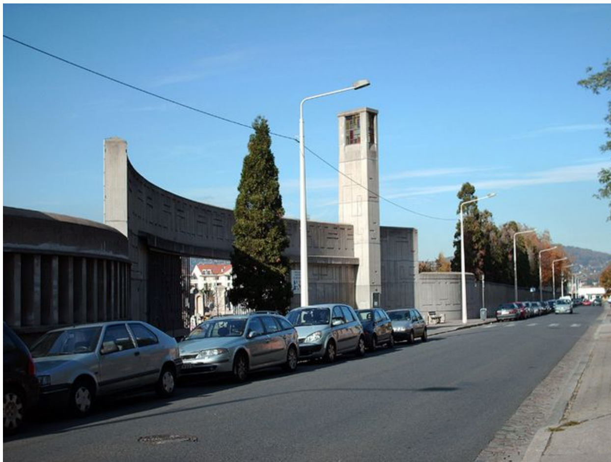
Le portail rue Philippe-de-Lassalle
