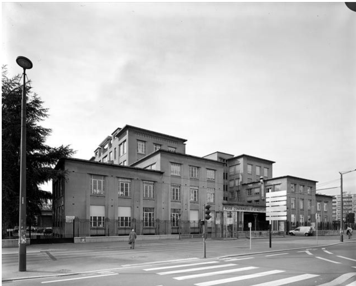
Vue générale du côté de l'entrée principale
