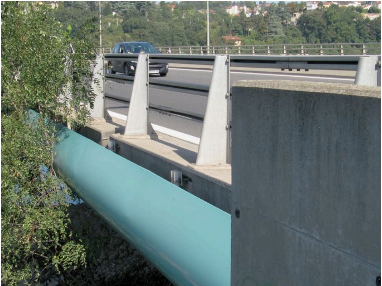
Tablier, de côté, face aval, vue de détail : fixation de la protection à la poutre (depuis la rive gauche)
