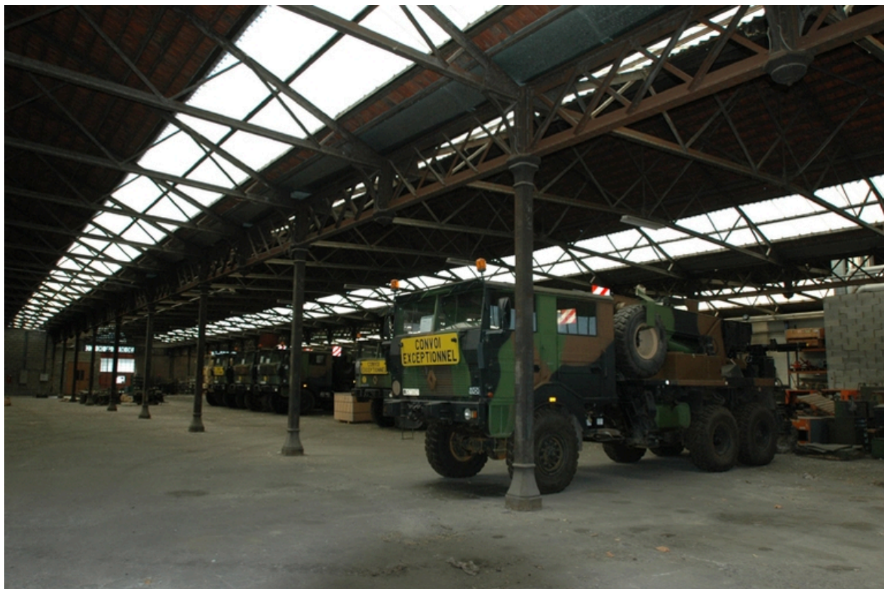
Détail poteaux en fonte
