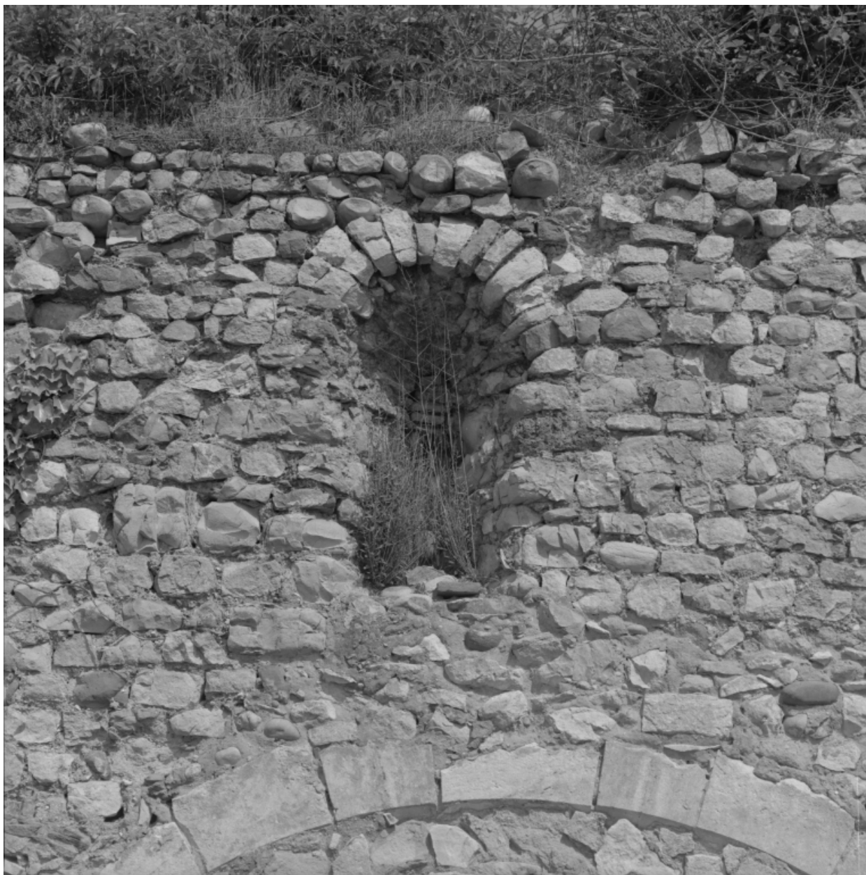
Détail : baie en plein cintre murée.
