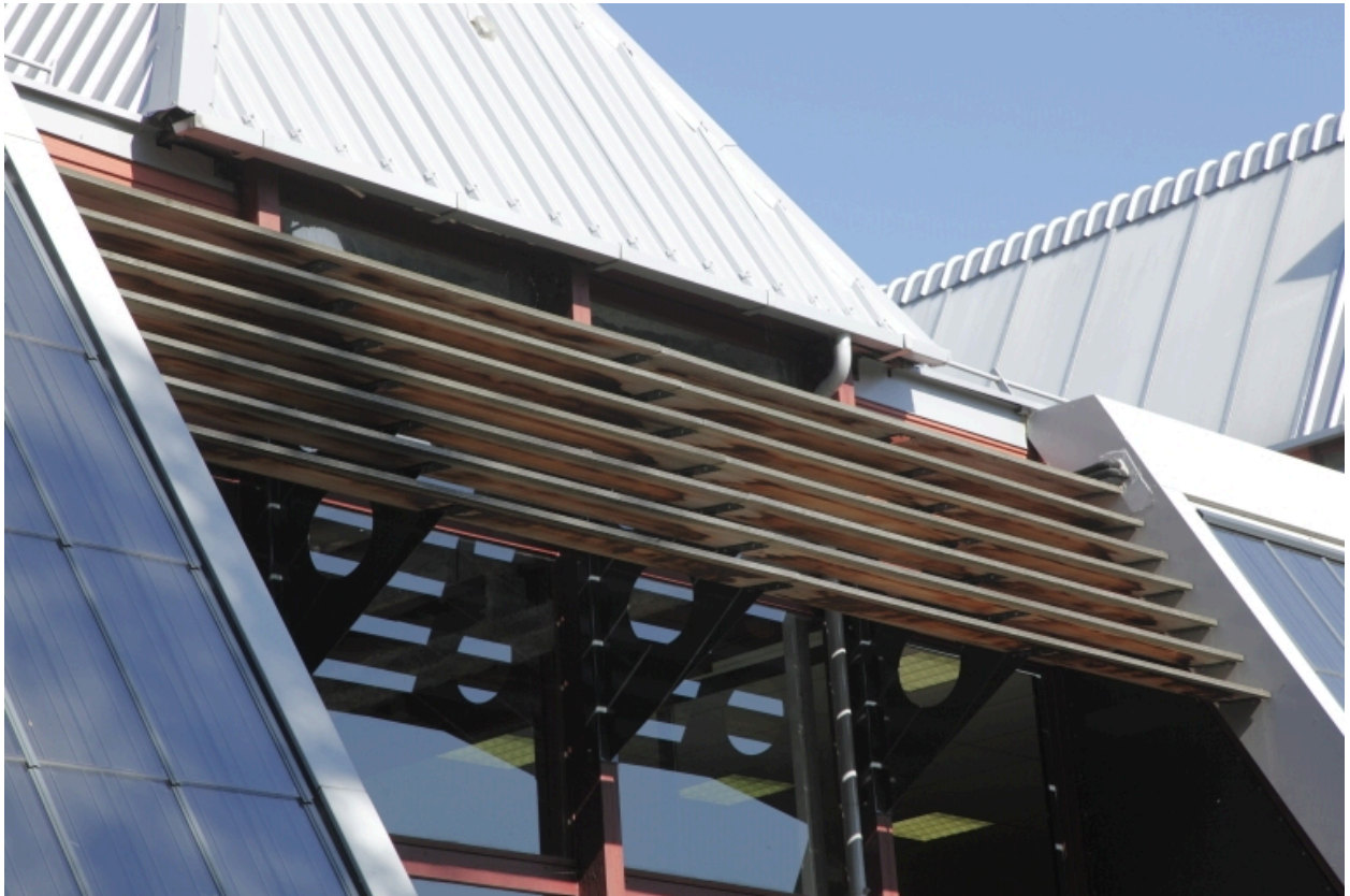
Bâtiment A, façade sud. Brise soleil.
