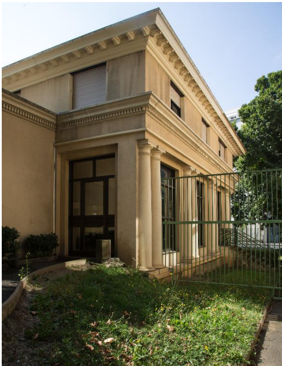
Entrée du bâtiment E
