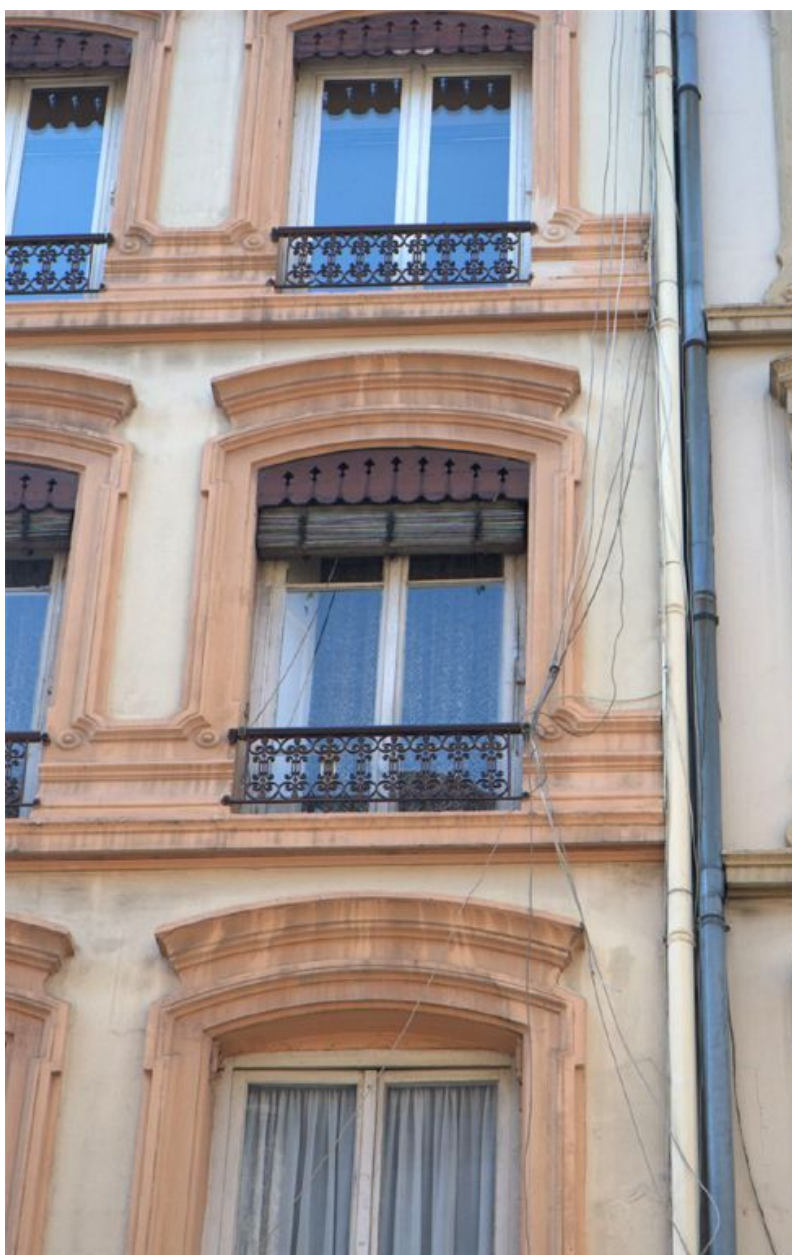
Elévation antérieure, détail d'une baie
