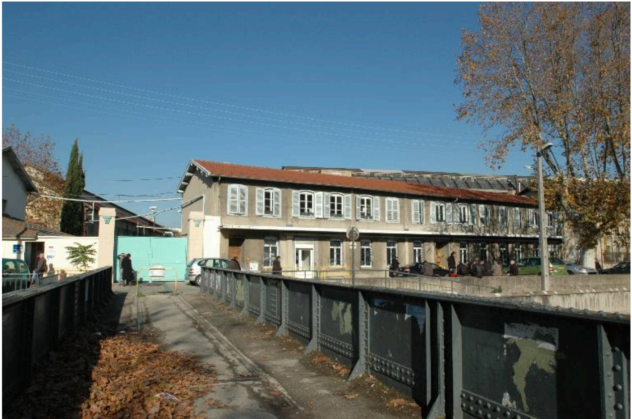
Entrée porte Yzeron, passerelle sur l'Yzeron, services sociaux et restaurant d'entreprise.
