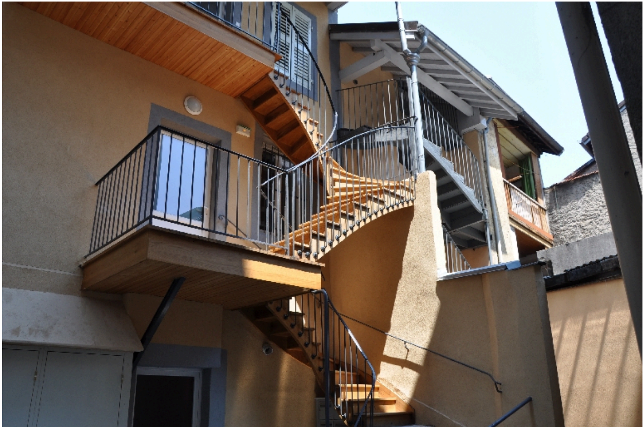
Détail de l'escalier extérieur, à gauche
