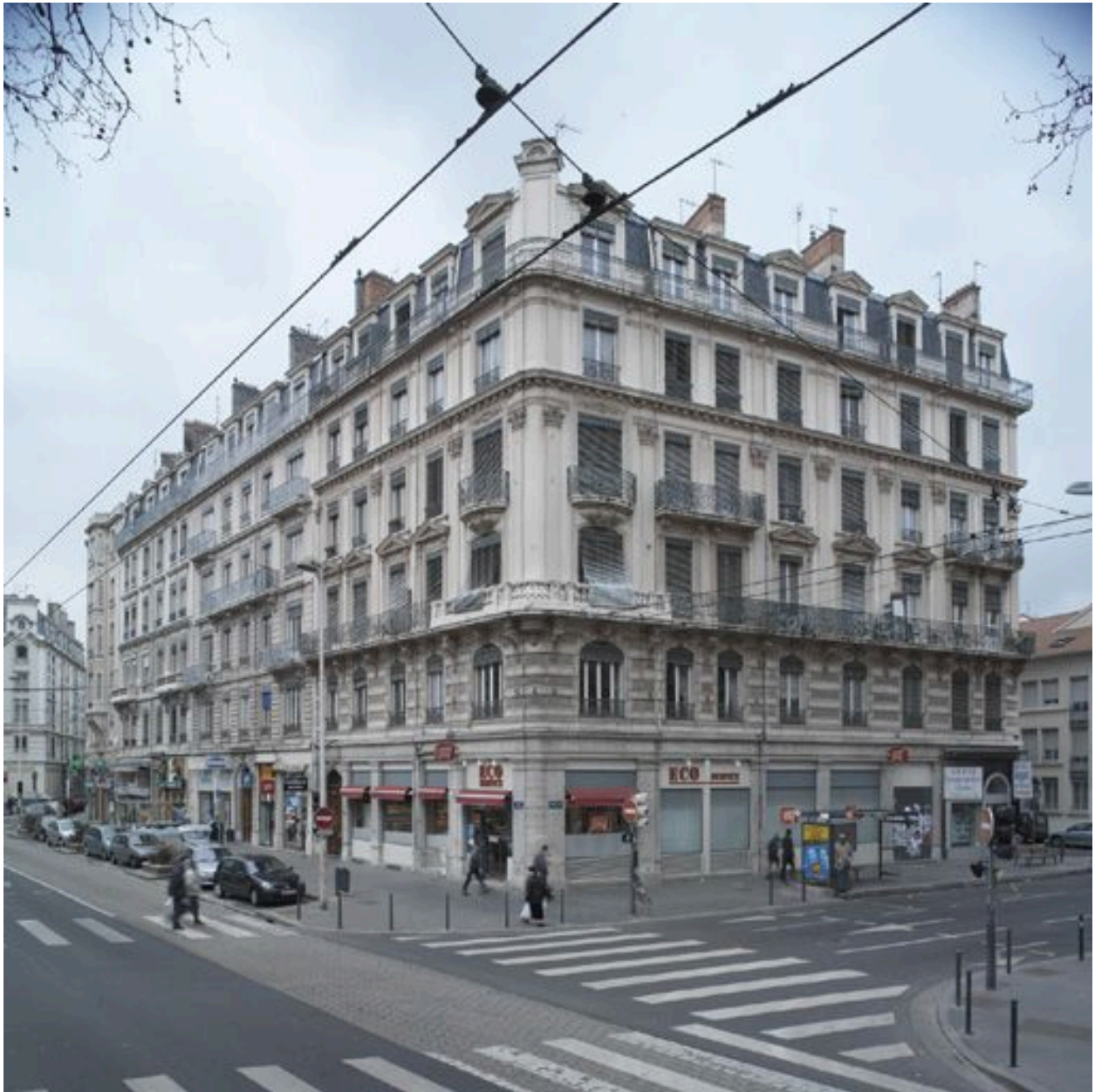
Vue générale depuis l'avenue Jean-Jaurès
