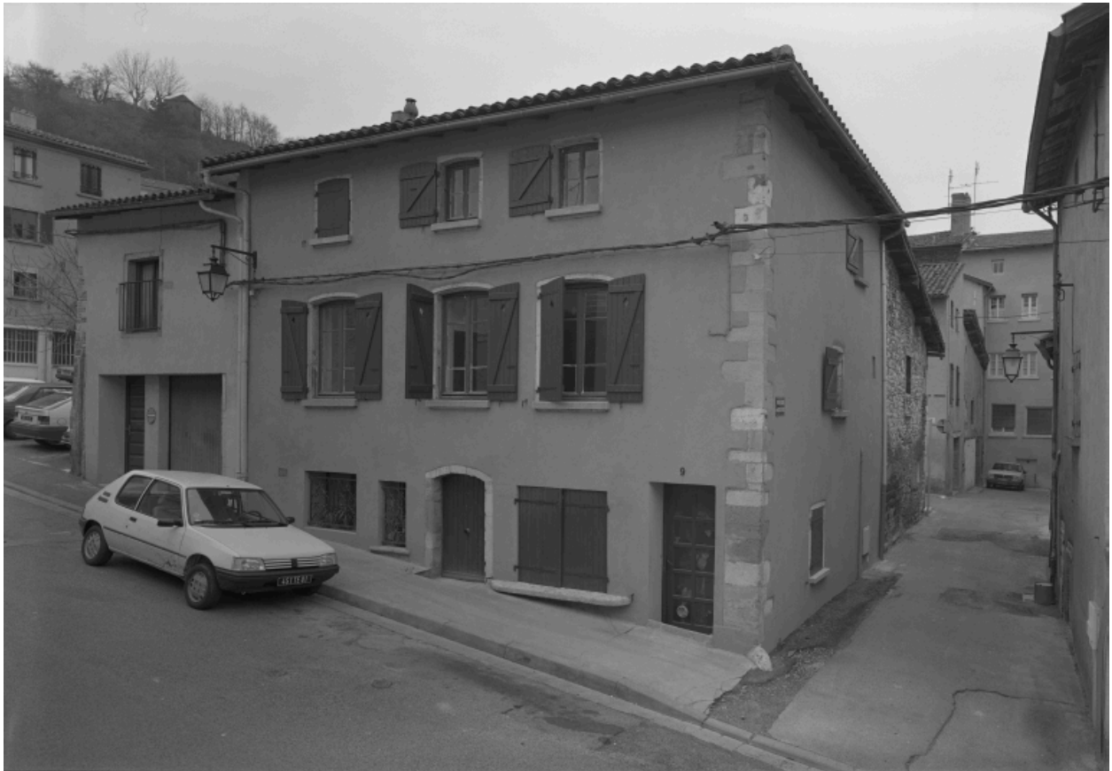
Maison de type III, 9 rue de l'Hôpital, avec baie d'ancienne boutique remaniée dans l'élévation principale.
