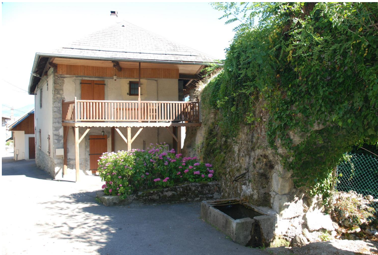
Vue ouest de l'ancien moulin à farine.
