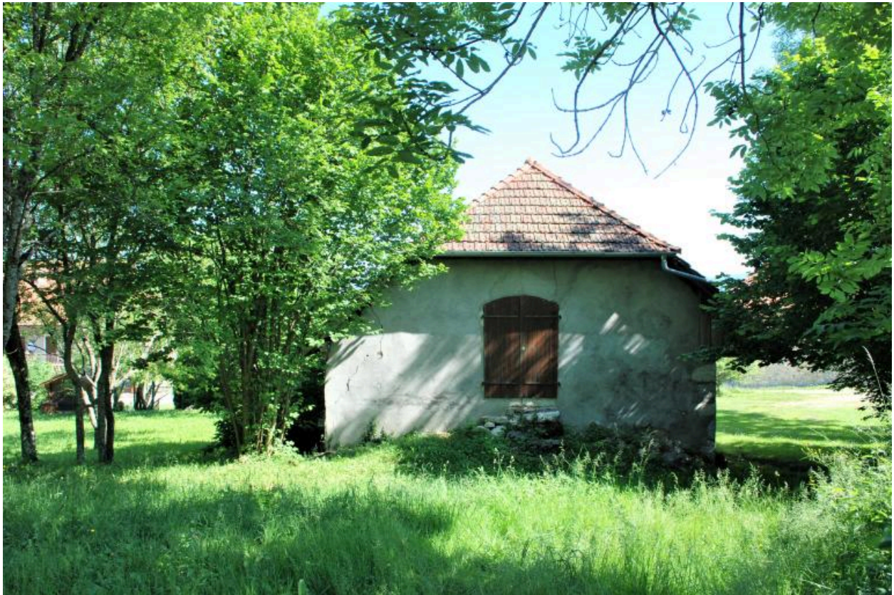
Vue d'ensemble du mur pignon sud
